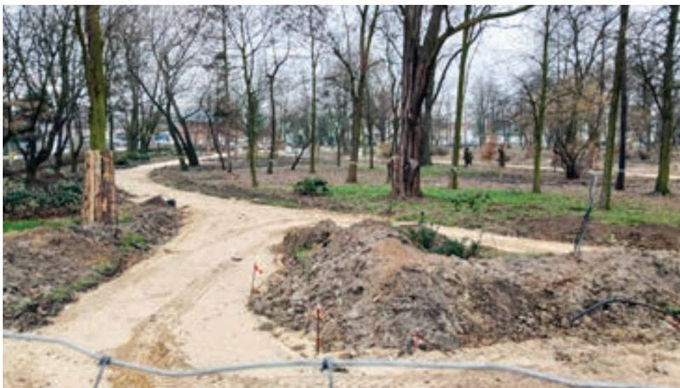
Na koniec marca w parku wykonanych było zaledwie 30% prac.
