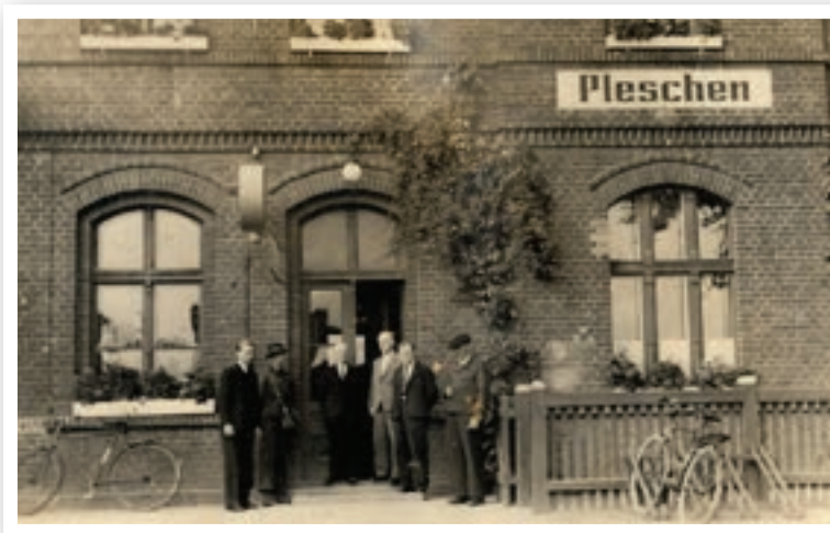
Pracownicy pleszewskiej kolejki wąskotorowej przed budynkiem dworca. Wśród nich Brunon Nikoleizig (trzeci od prawej)
