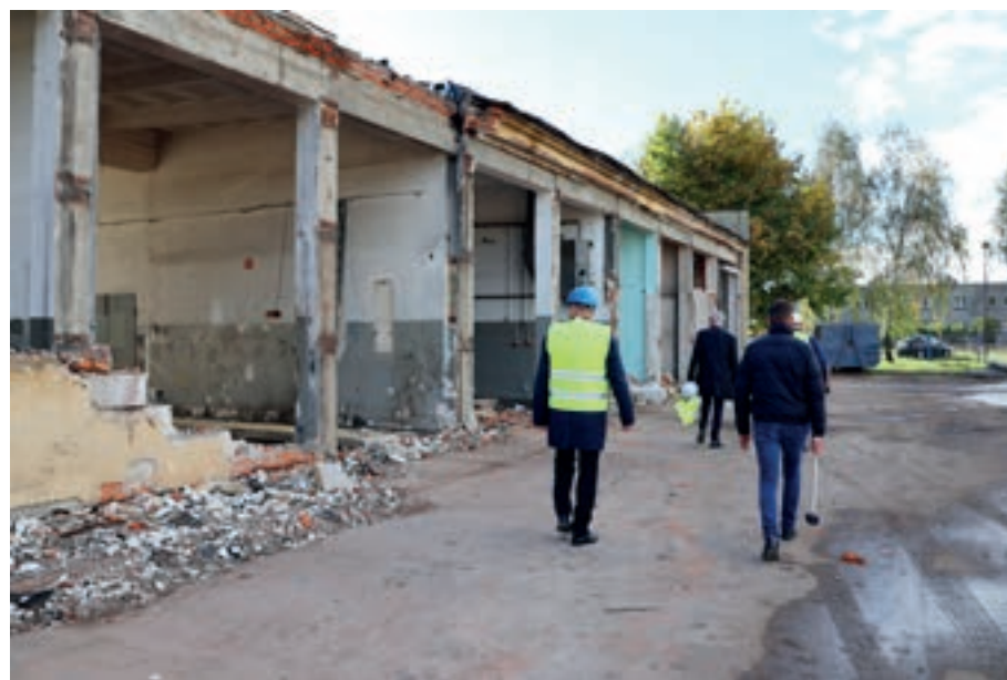
Pierwszy etap inwestycji to wyburzenie starych budynków.
