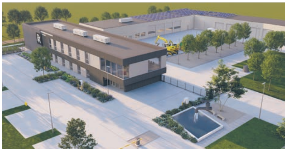
Tak ma się prezentować nowa Centralna Stacja Wodociągowa w Pleszewie.
