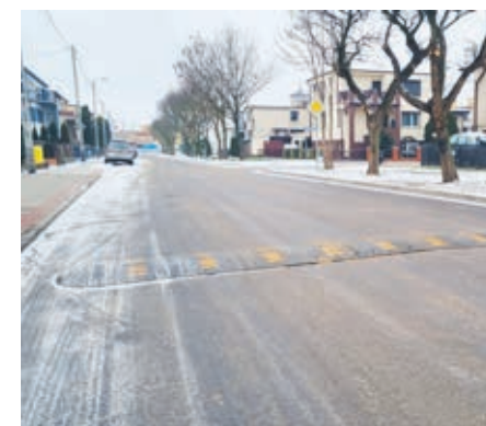
Remont na os. Jordanowskim objął ponad 770 m dróg.
