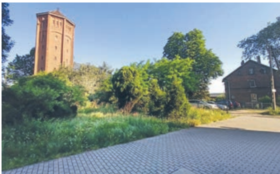
Nowy parking powstanie przy torowisku w sąsiedztwie wieży ciśnień w Kowalewie.
