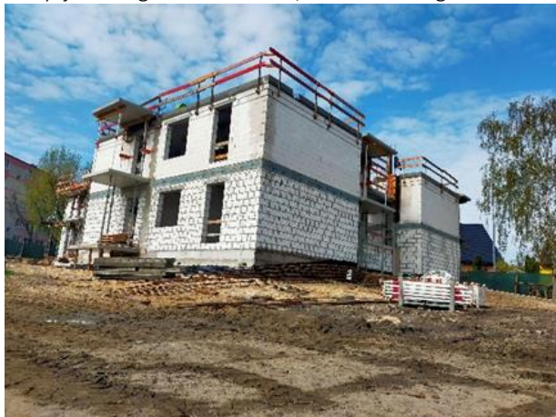
Zdjęcie 14. Aktualny stan inwestycji u zbiegu ulic Mieszka I, Poniatowskiego i Warneńczyka.
