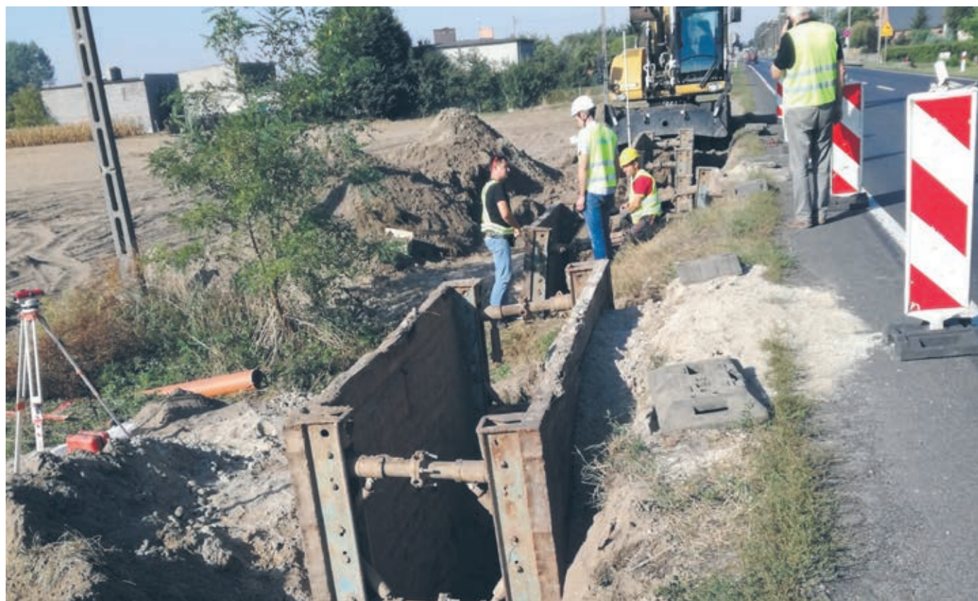
Jeździmy po coraz lepszych drogach w mieście i na wsiach. Na zdjęciu prace kanalizacyjne w Suchorzewie.
